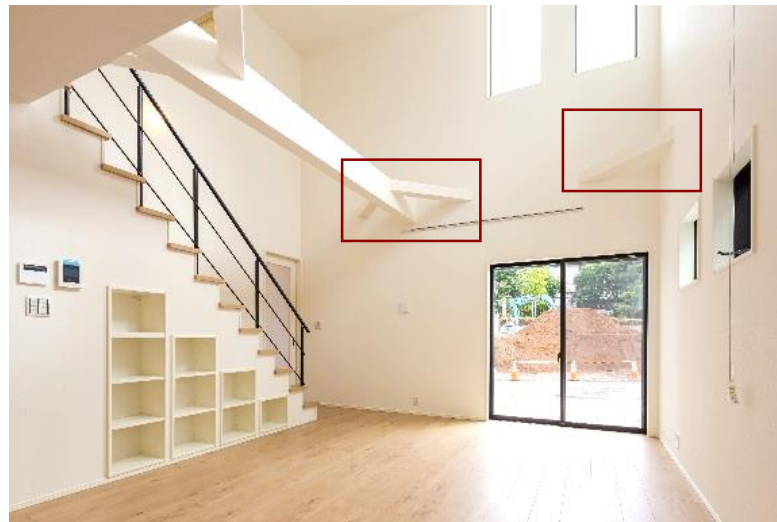
□ 火打ち材が露出している箇所
